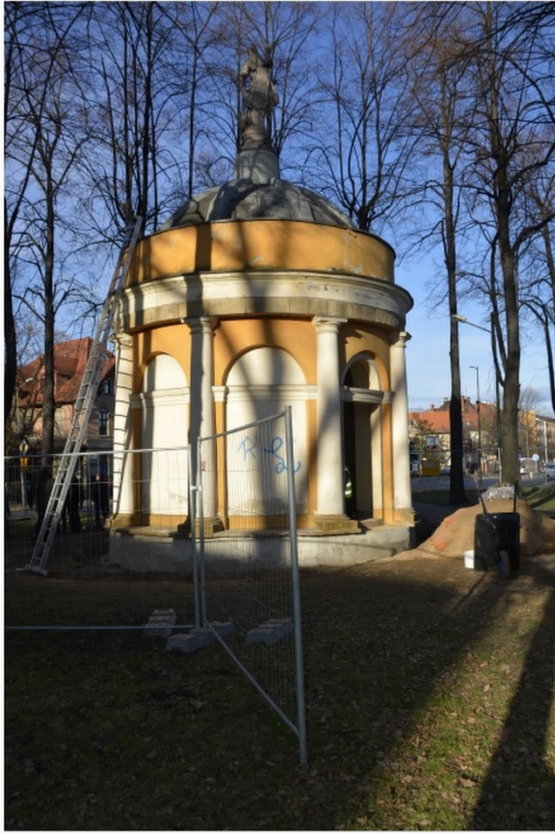
Przed i po modernizacji
