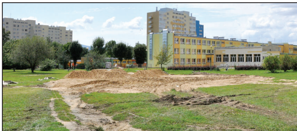
Trwa budowa pierwszego w naszym powiecie miasteczka ruchu drogowego
