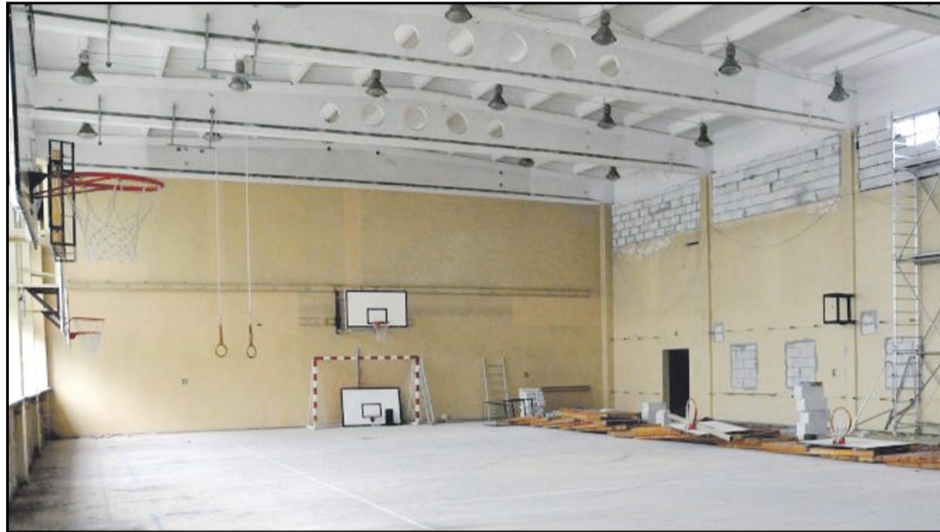
W ramach inwestycji remontowana jest duża sali gimnastyczna, w SP nr 5 powstaną także specjalne pomieszczenia do gimnastyki korekcyjnej
