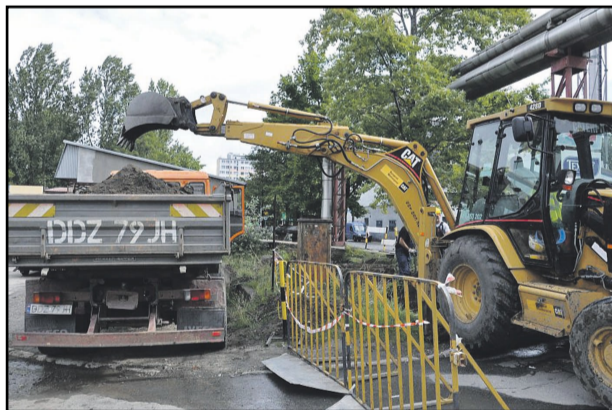
Rozpoczęła się budowa drogi na terenach dawnej Diory
