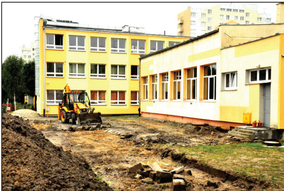
Trwają prace przy zagospodarowaniu terenu wokół Szkoły Podstawowej nr 5. W tym roku obejmą one budowę ciągów komunikacyjnych
