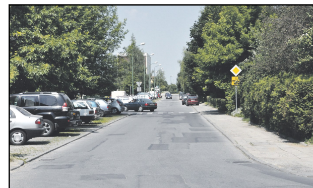
Trwająca do listopada inwestycja obejmuje remont drogi i oświetlenia od Biedronki do kościoła
