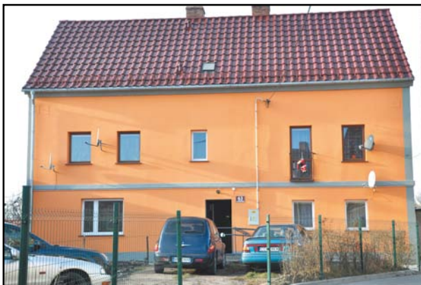
Dzięki temu programowi ulice miasta pięknieją. Przykładem jest ul. Brzegowa. Wspólnota z Brzegowej 63 otrzymała w 2011 r. na remont elewacji 10 tys. zł
