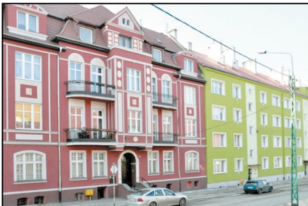
15 tys. zł na remont elewacji otrzymała w I edycji programu wspólnota budynku przy ul. 11 Listopada 1
