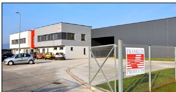
Pomieszczenia produkcyjno-magazynowe i biurowe znalazły w drugiej hali Invest-Park Development w DPP dwie firmy
