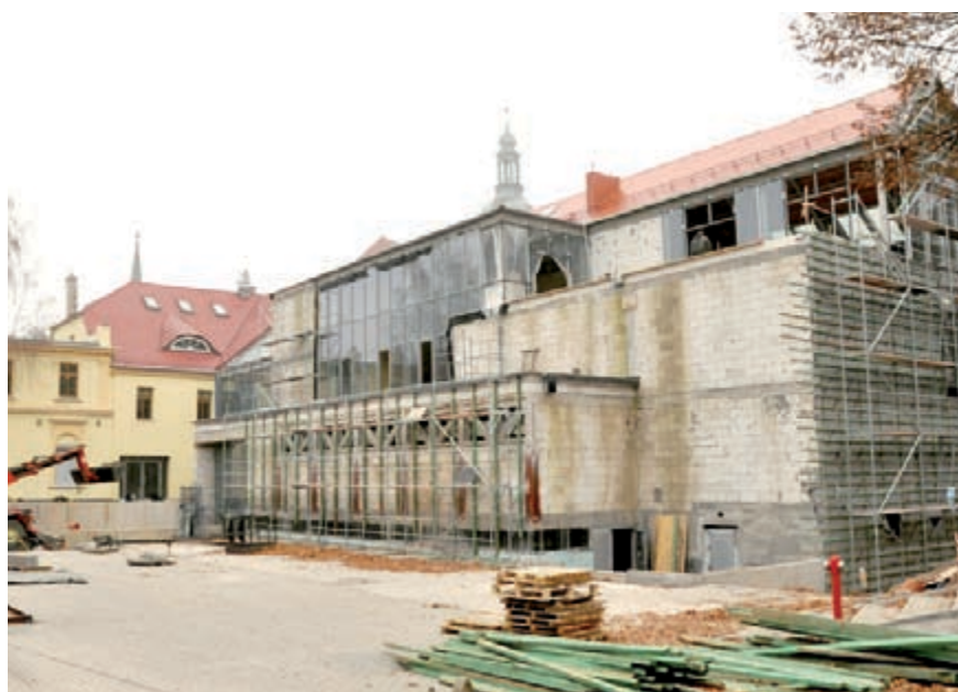
W 2012 roku w wybudowanym już nowym obiekcie realizowane będą prace wykończeniowe. Rozbudowa Dzierżoniowskiego Ośrodka Kultury możliwa jest dzięki unijnemu dofinansowaniu pokrywającemu dwie trzecie kosztów zadania
