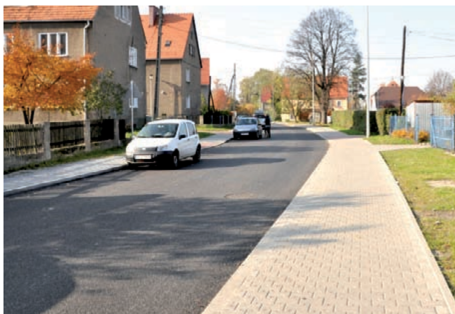
Zakończona w tym roku gruntowna przebudowa ul. Brzegowej zrealizowana została w oparciu o unijne dofinansowanie (4 mln zł). To była trudna, ale bardzo potrzebna inwestycja, która oprócz komfortu znacząco wpłynie na poprawę bezpieczeństwa pieszych
