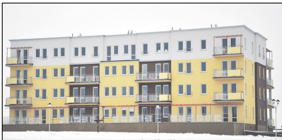
Zakończyła się budowa pierwszego z kilkunastu budynków, które przy ul. Złotej wybuduje Invest-Park Development
