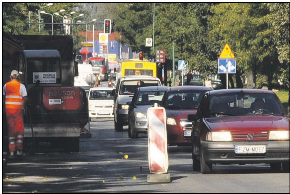
W listopadzie na ul. Piastowskiej i Kościuszki układana będzie nowa nawierzchnia
