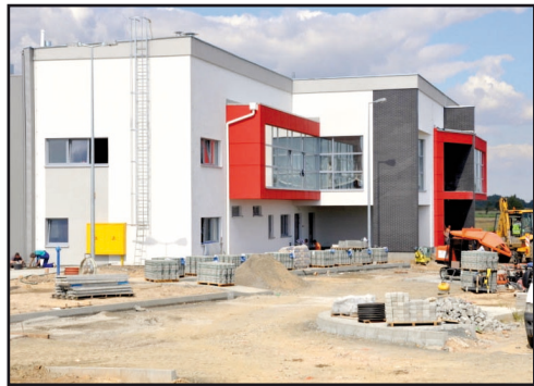
W wybudowanej w Dzierżoniowskim Parku Przedsiębiorczości hali trwają prace wykończeniowe
