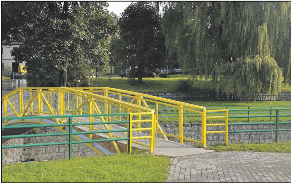
Drobne prace remontowe wpływają na poprawę wizerunku i czystość w Dzierżoniowie
