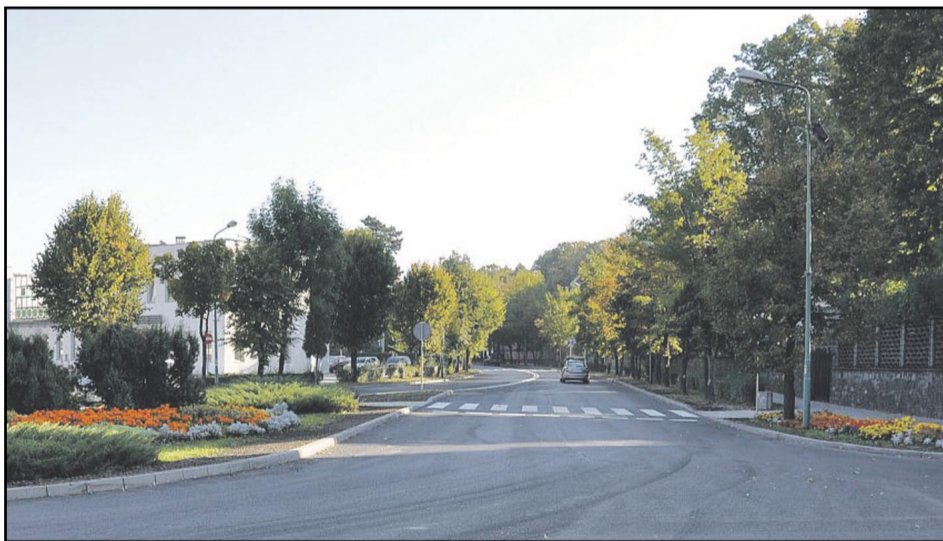
Zakończyła się modernizacja ul. Daszyńskiego. W tym roku nową nawierzchnię zyskają także ulica Kościuszki i Piastowska
