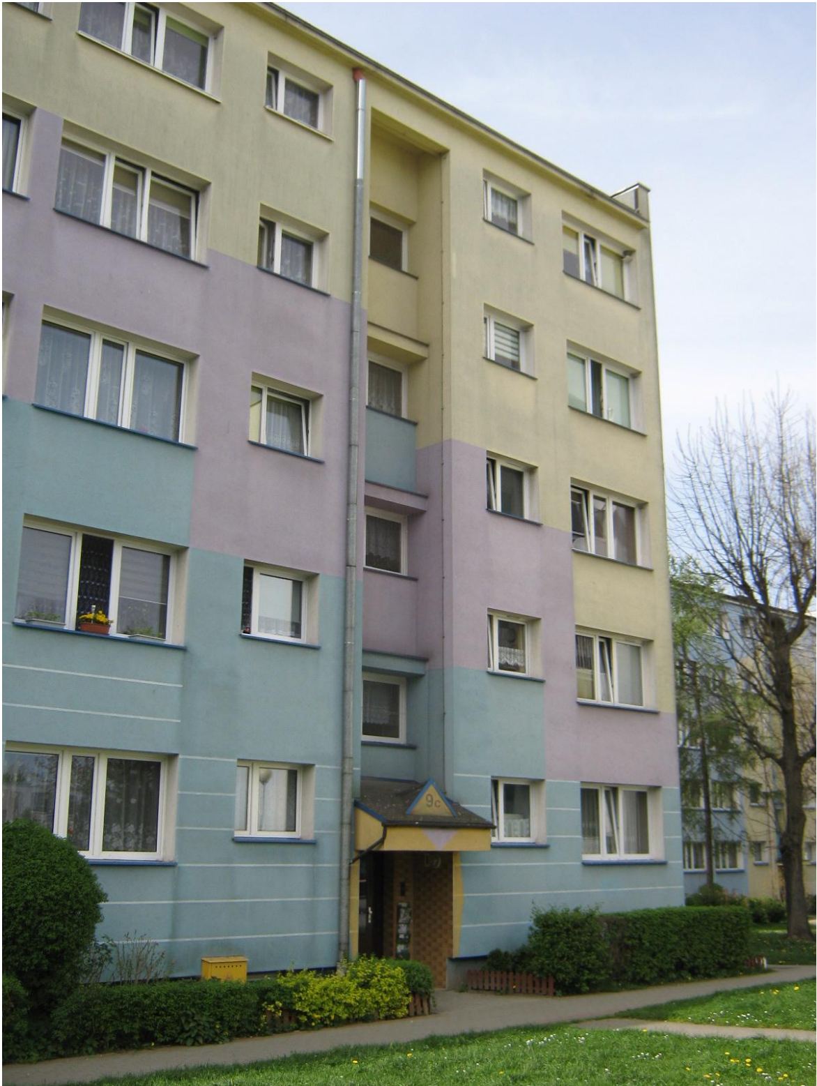
Lokal mieszkalny nr 14, Osiedle Błękitne 9c
